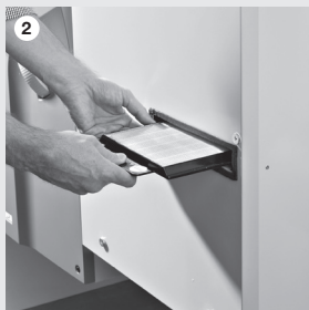
Eemaldage filter, kontrollige selle määrdumist
