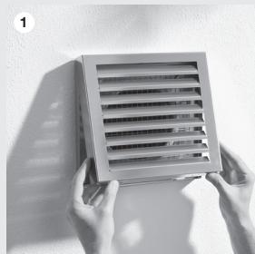
1 Keerake lahti välisresti alumisel küljel olevad kruvid ja eemaldage kattevõre
