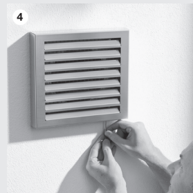
4 Paigaldage välisrest uuesti tagasi
