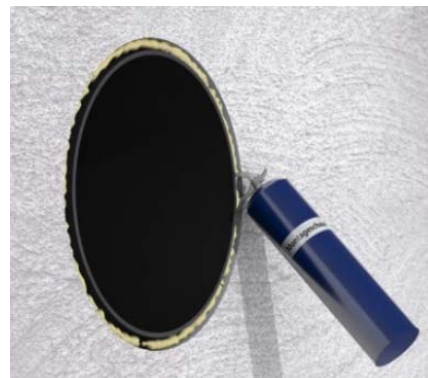
Abb. 5 Wandeinbaurohr abdichten
